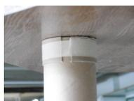
Capitel de las columnas: un trozo de tubo abierto mediante un corte y pegado con cola blanca y cinta de pintor al fuste.
