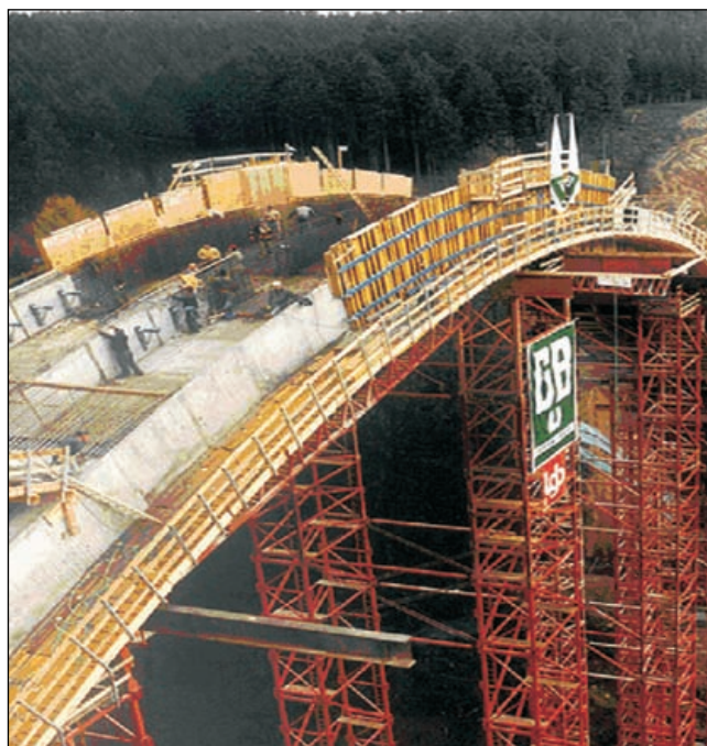
Figura 1. Cercha de puente en construcción.
