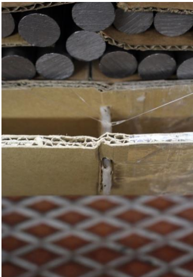
Detalle de la viga central
