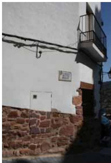
Figura 32: Fachada de piedra revocada y zócalo de piedra visto. Villafamés (Castellón) Foto: G. Gómez
