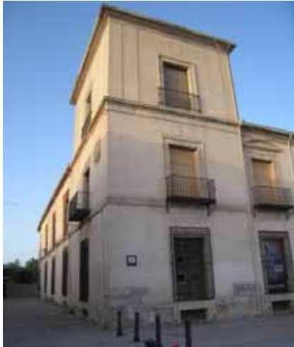
Figura 13: Fachada de piedra revocada Palacio del Duque de Medinaceli (Soria) Foto M. de Luxán
