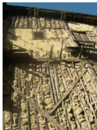
Figura 22: Entramados tradicionales en La Alberca (Salamanca). Foto: Fco. J. González
