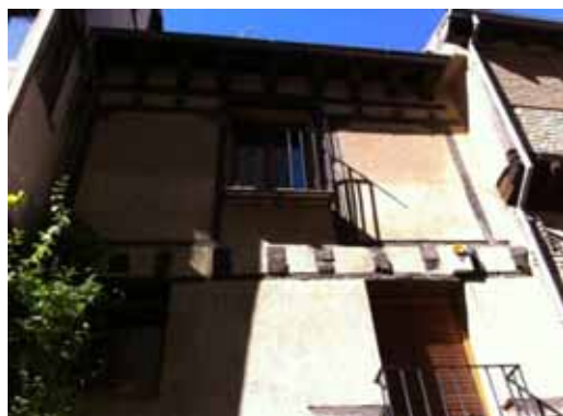
Figura 24. Entramado tradicional restaurado eliminando revoco en elementos de madera en La Alberca (Salamanca). Foto: Fco. J. González
