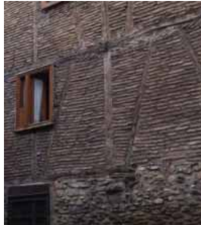
Figura 27. Fachada desollada de entramado de ladrillo en Vitoria. Foto: E. Román
