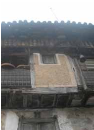
Figura 20: Entramados tradicionales en La Alberca (Salamanca). Foto: Fco. J. González
