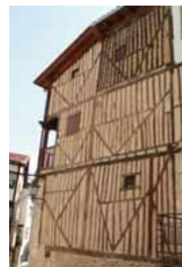
Figura 25. Entramado tradicional restaurado eliminando revoco en elementos de madera en La Alberca (Salamanca). Foto: M.Mar Barbero-Barrera
