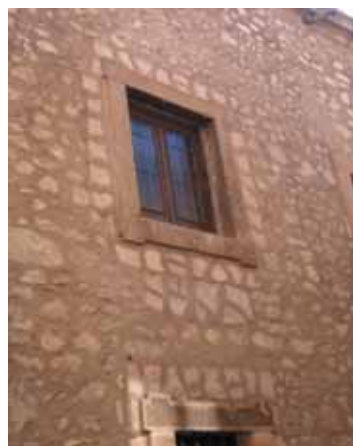
Figura 16. Enmarcado de hueco en Sepúlveda (Segovia). Foto M. de Luxán
