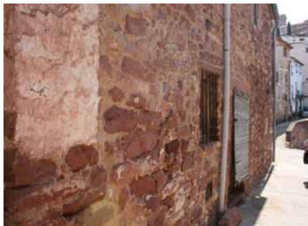
Figura 9: Sustitución del revoco tradicional exterior por sólo relleno de juntas en Villafamés (Castellón) Foto G. Gómez
