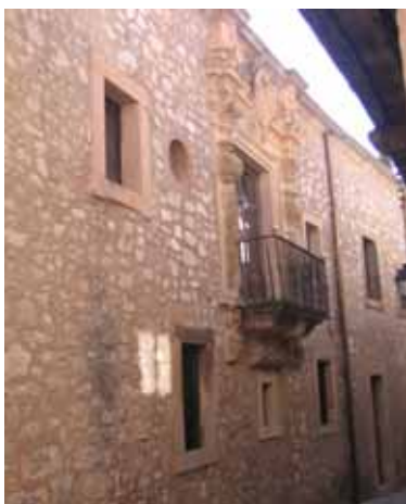
Figura 15. Fachada en Sepúlveda (Segovia). Foto M. de Luxán
