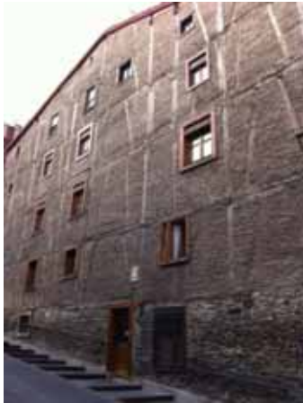
Figura 26. Fachada desollada de entramado de ladrillo en Vitoria. Foto: E. Román
