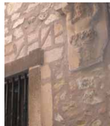
Figura 17. Detalle falsas juntas. Sepúlveda (Segovia). Foto M. de Luxán
