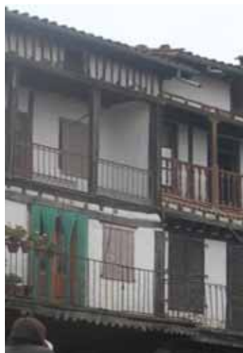
Figura 21: Entramados tradicionales en La Alberca (Salamanca). Foto: Fco. J. González
